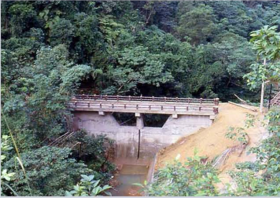
臺中市中部科學園區林厝公園（原東一滯洪池）| 照片來源：段錦浩 | 2008 | 7 | 21
