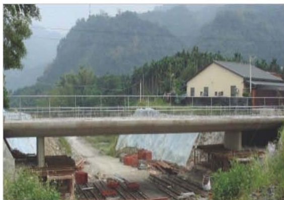
南投石灼巷 6 號高速公路上跨越橋之預力輕質混凝土版梁 | 照片來源：顏聰
