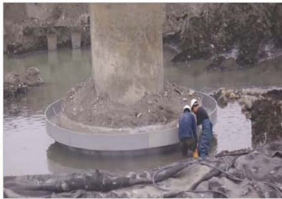
上鉤式頸環防治原理示意圖及現場施工 | 照片來源：陳樹群 | 2009
