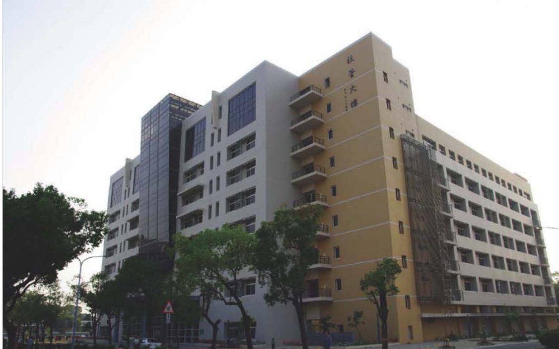
社管大樓 | 攝影：張均東 | 2009 | 2 | 15
