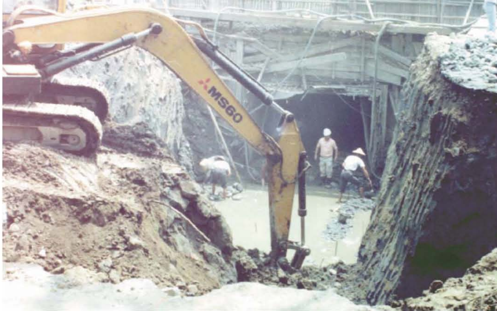
忠明南路地下化整建工程 | 照片來源：中興大學秘書室
