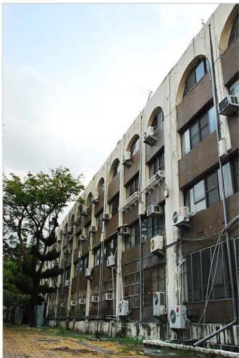
弘道樓背側人行磚道
