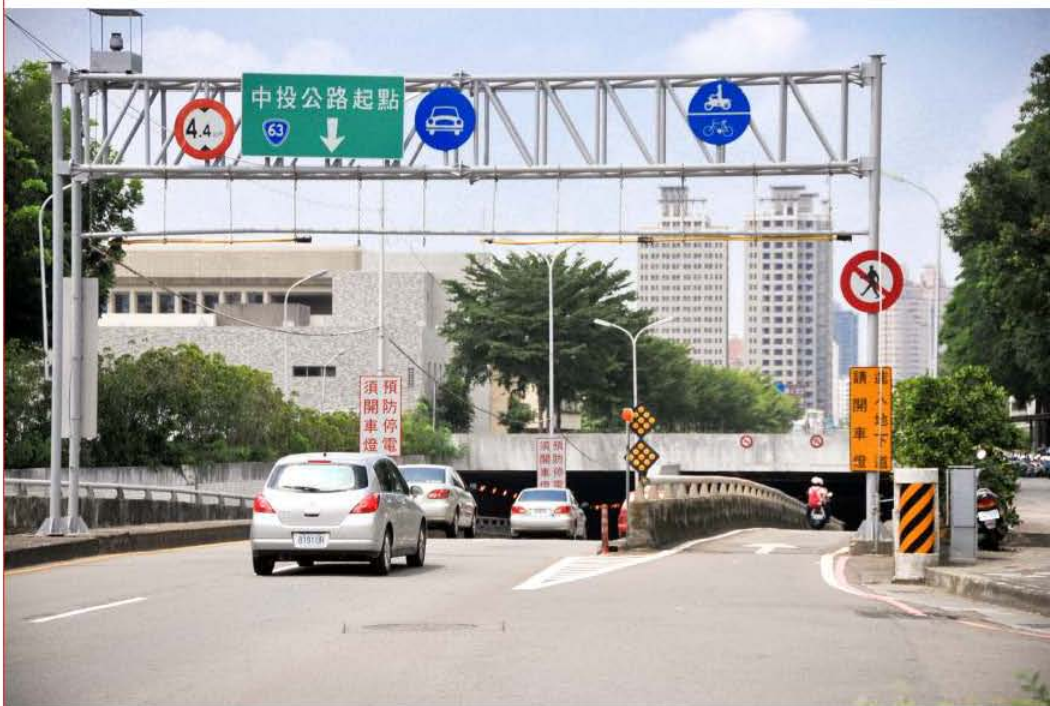
上圖 志明南路地下化整建工程 照片來源：中興大學秘書室
